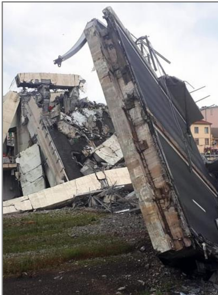
Chiuso al traffico il 14 agosto 2018 , a seguito del collo parziale della struttura, che ha provocato 43 morti e 566 sfollati .
