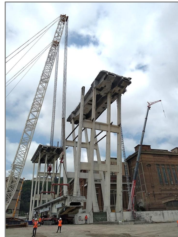
Demolizione avviata nel gennaio 2019 poi terminata il 12 agosto 2019
